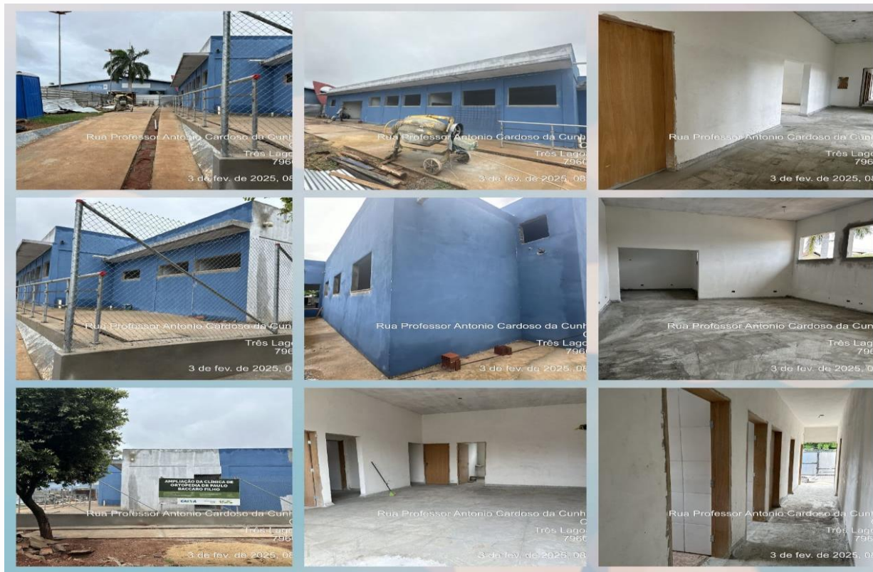
CLÍNICA DE REABILITAÇÃO - 100% da obra concluída
