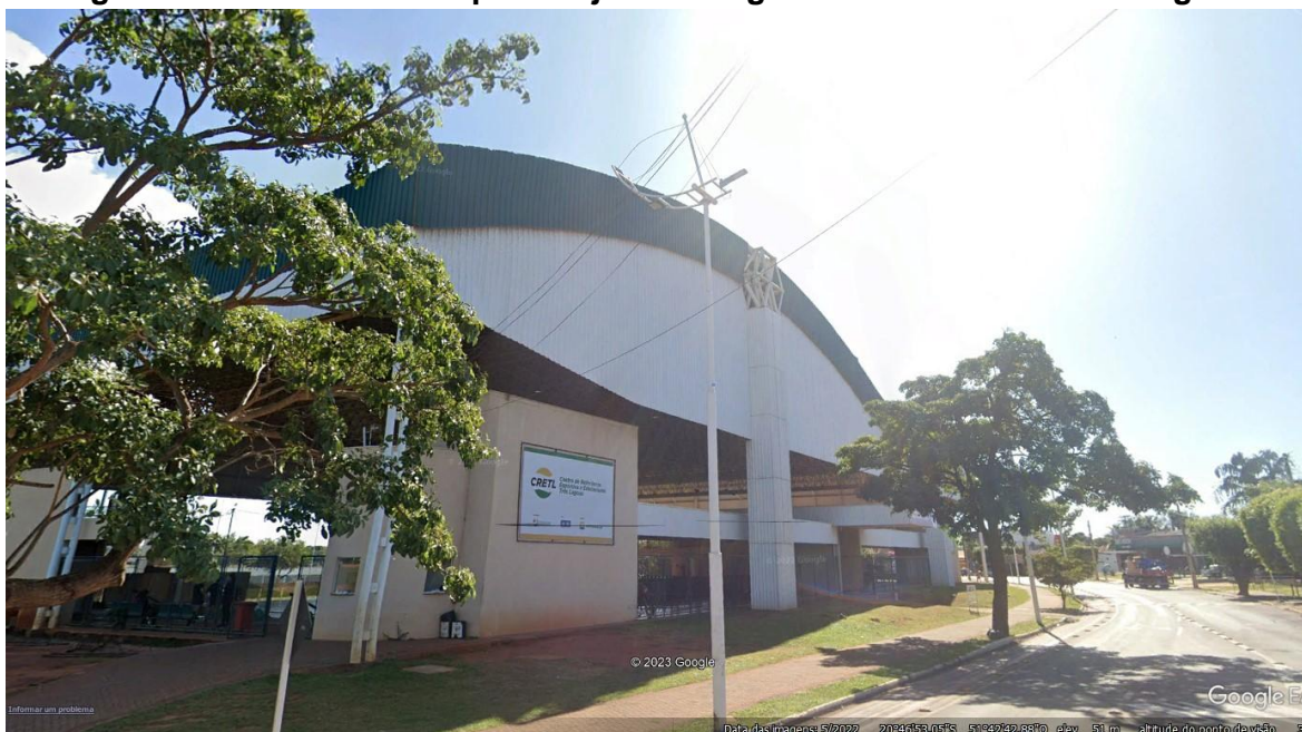
Figura 6.3.4.1- 4 Centro Esportivo junto à Lagoa Maior – Circuito das Lagoas.
