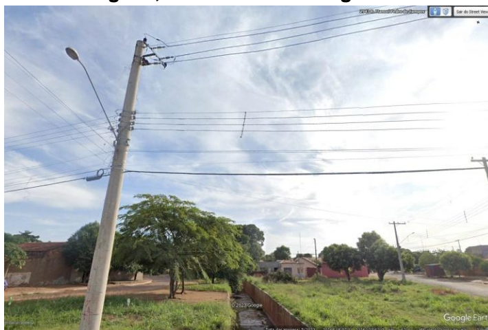
Figura 5.3- 2 Imagem da canalização do Córrego Brasília e antropização das margens, Cidade de Três Lagoas/MS.
