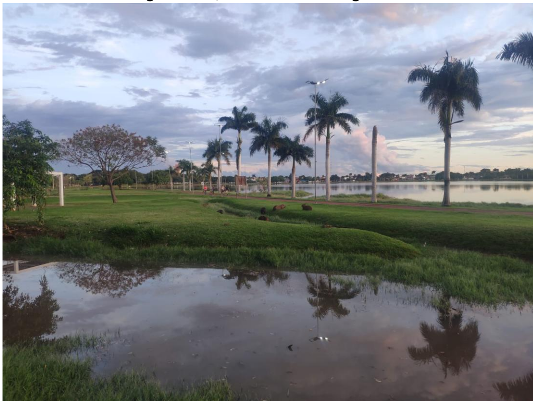
Figura 5.3- 6 Imagem de reservatório de contenção das águas de chuva junto à Lagoa Maior, Cidade de Três Lagoas/MS
